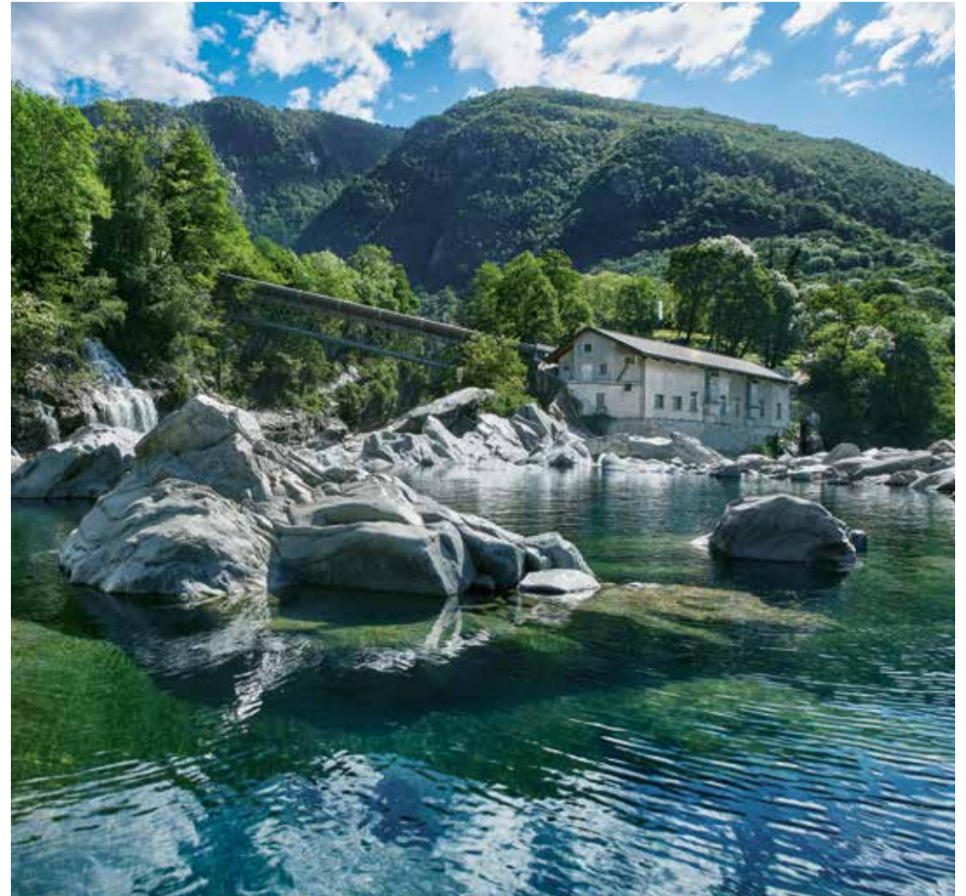
La centrale idroelettrica di Ponte Brolla
