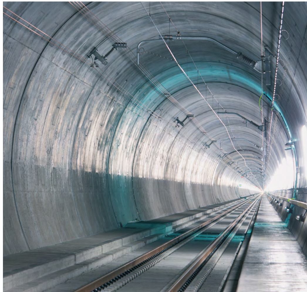
La galleria di base del San Gottardo
