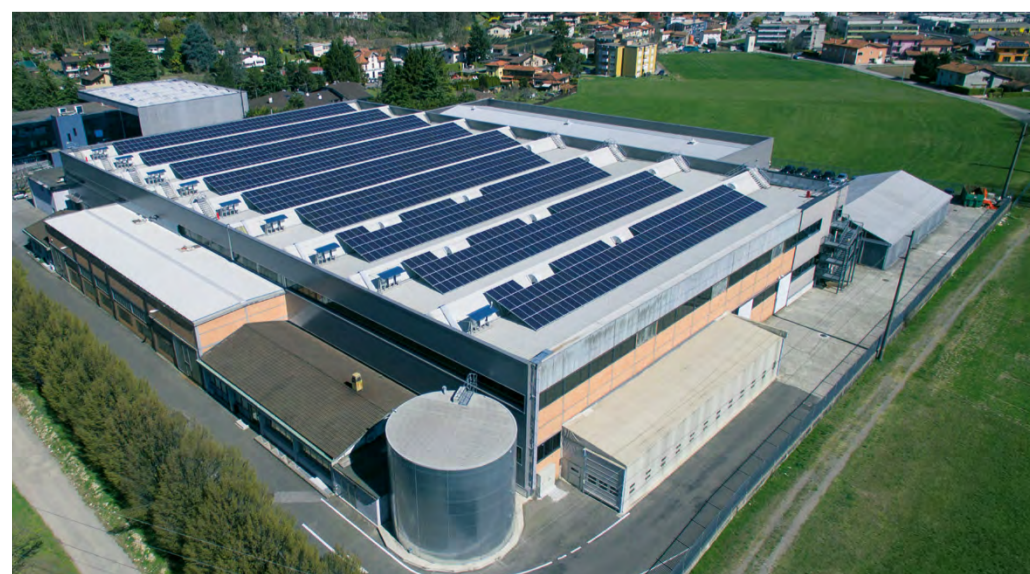
L'impianto fotovoltaico recentemente inaugurato a Stabio
