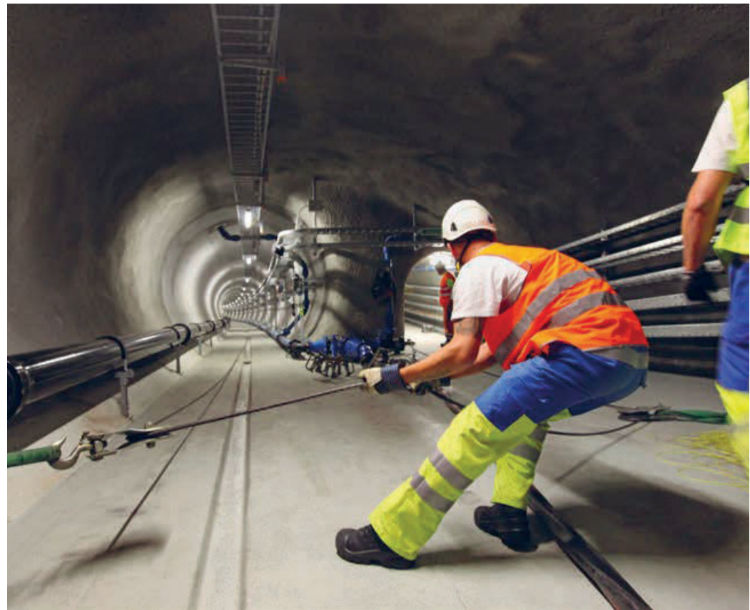
La rete elettrica svizzera dovrà essere sviluppata e ammodernata per adattarsi alle nuove esigenze.
