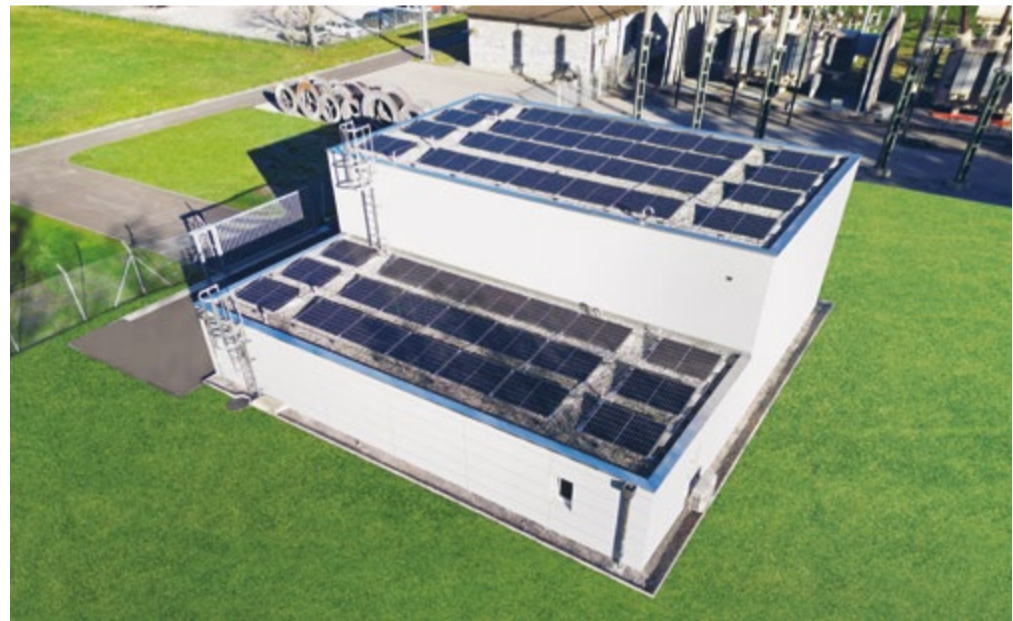
L'edificio della nuova sottostazione.
