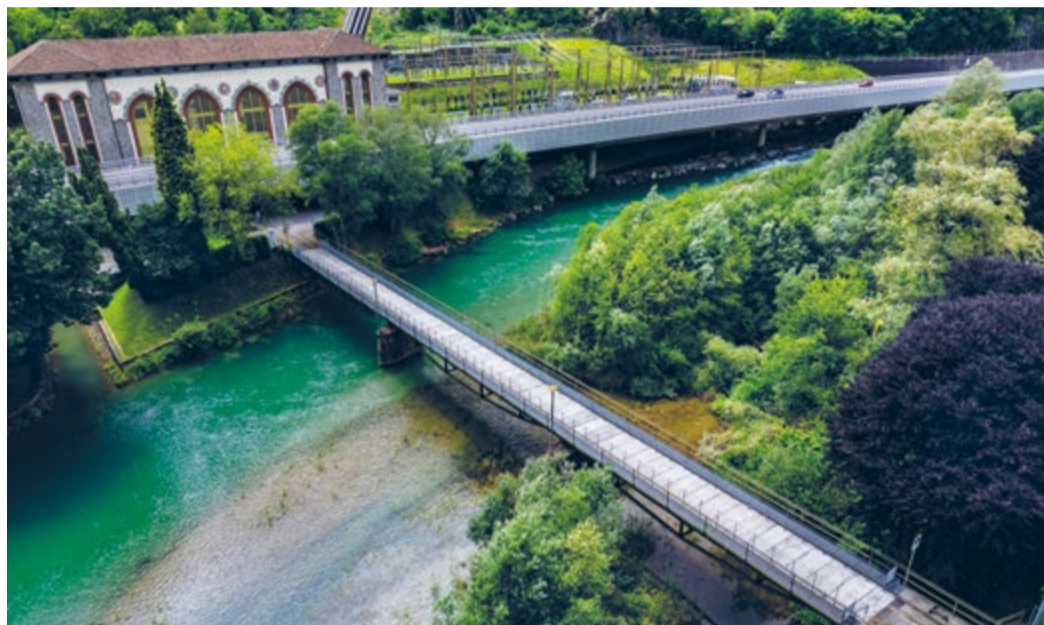
Il ponte del Piottino dopo il rinnovo
