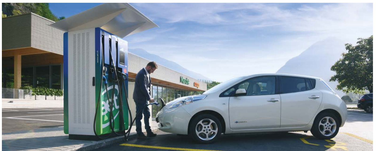
La nuova stazione di ricarica AET presso l'area di servizio di Bellinzona Nord
