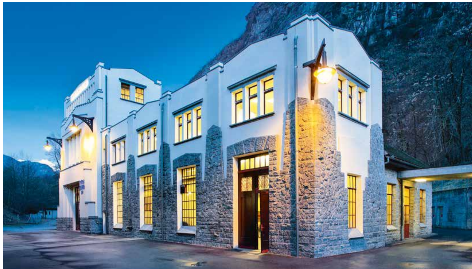
La centrale della Vecchia Biaschina, le cui facciate sono state restaurate nel 2014
