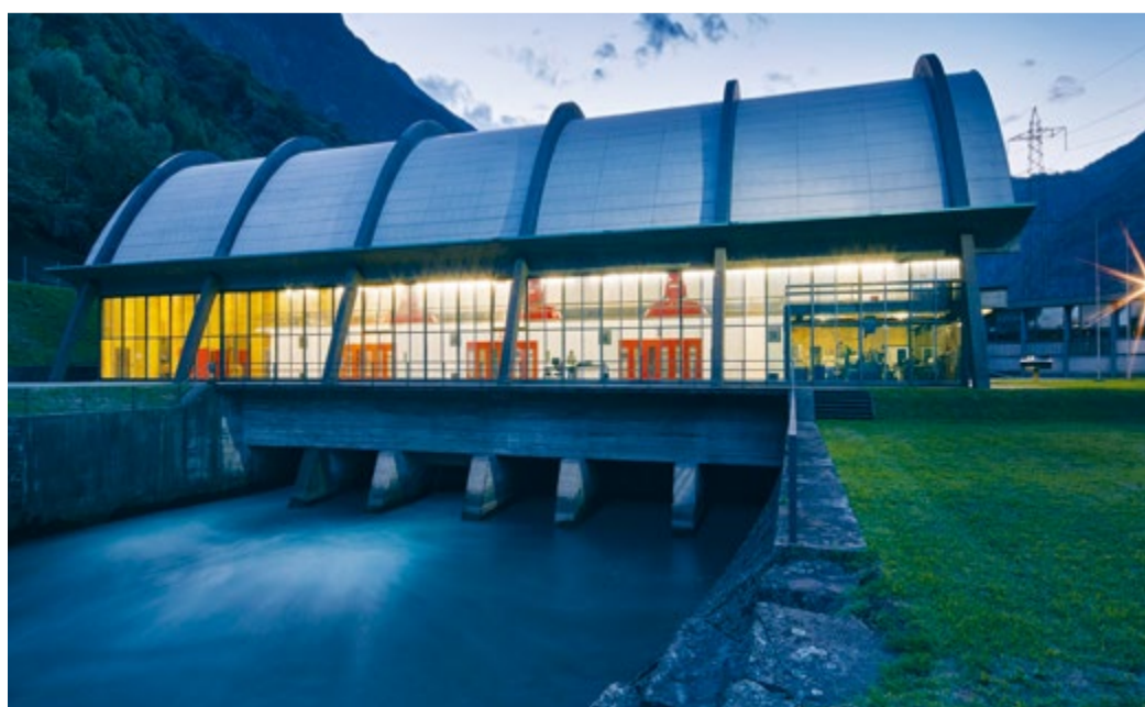
L'idroelettrico è la colonna portante della produzione svizzera. Nella foto la centrale Nuova Biaschina di AET
