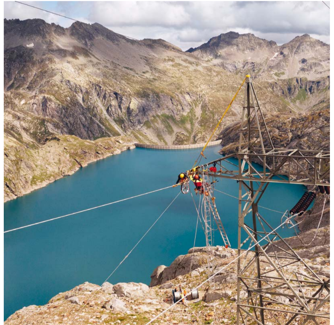
Lavori di manutenzione in alta quota sulle linee di Swissgrid. Fotografia: ©Swissgrid
