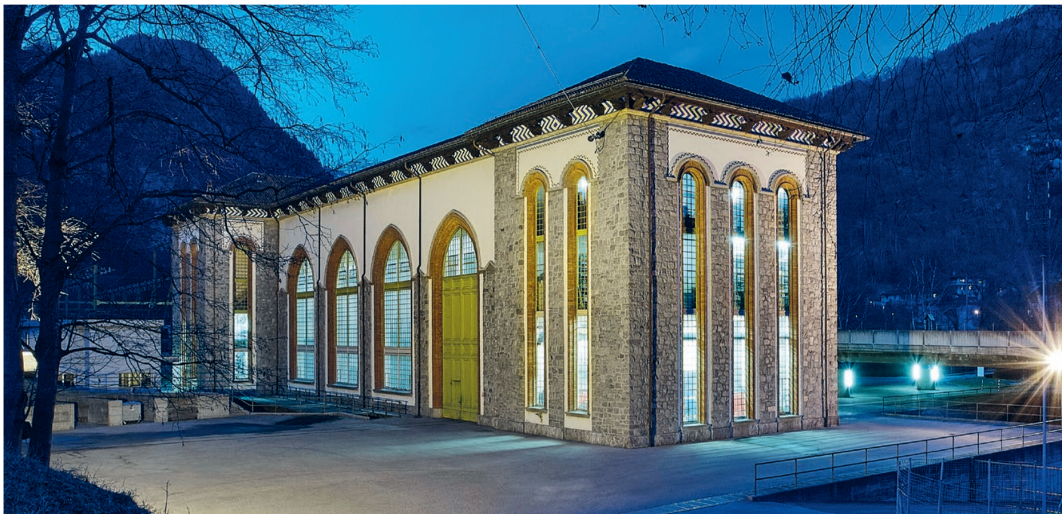
L'edificio della centrale del Piottino, progettato dall'architetto Giovanni Greppi
