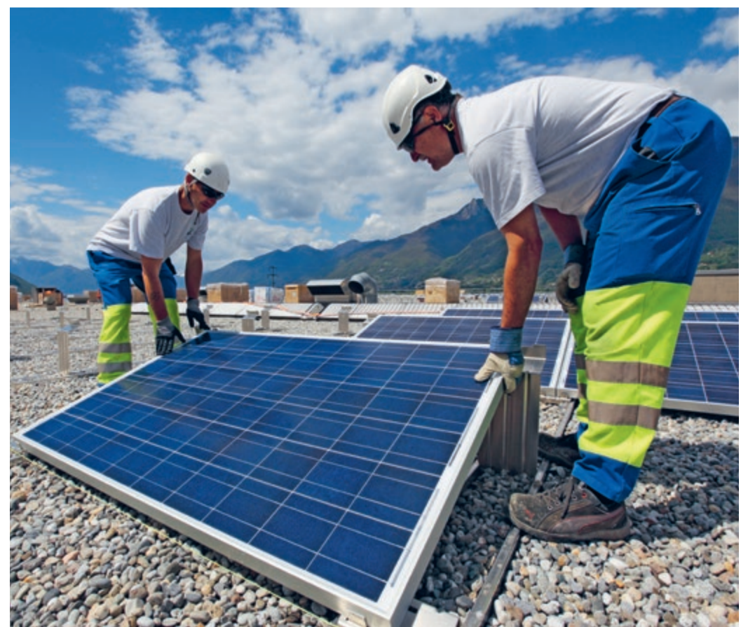
Tecnici AET durante l'installazione di un impianto fotovoltaico
