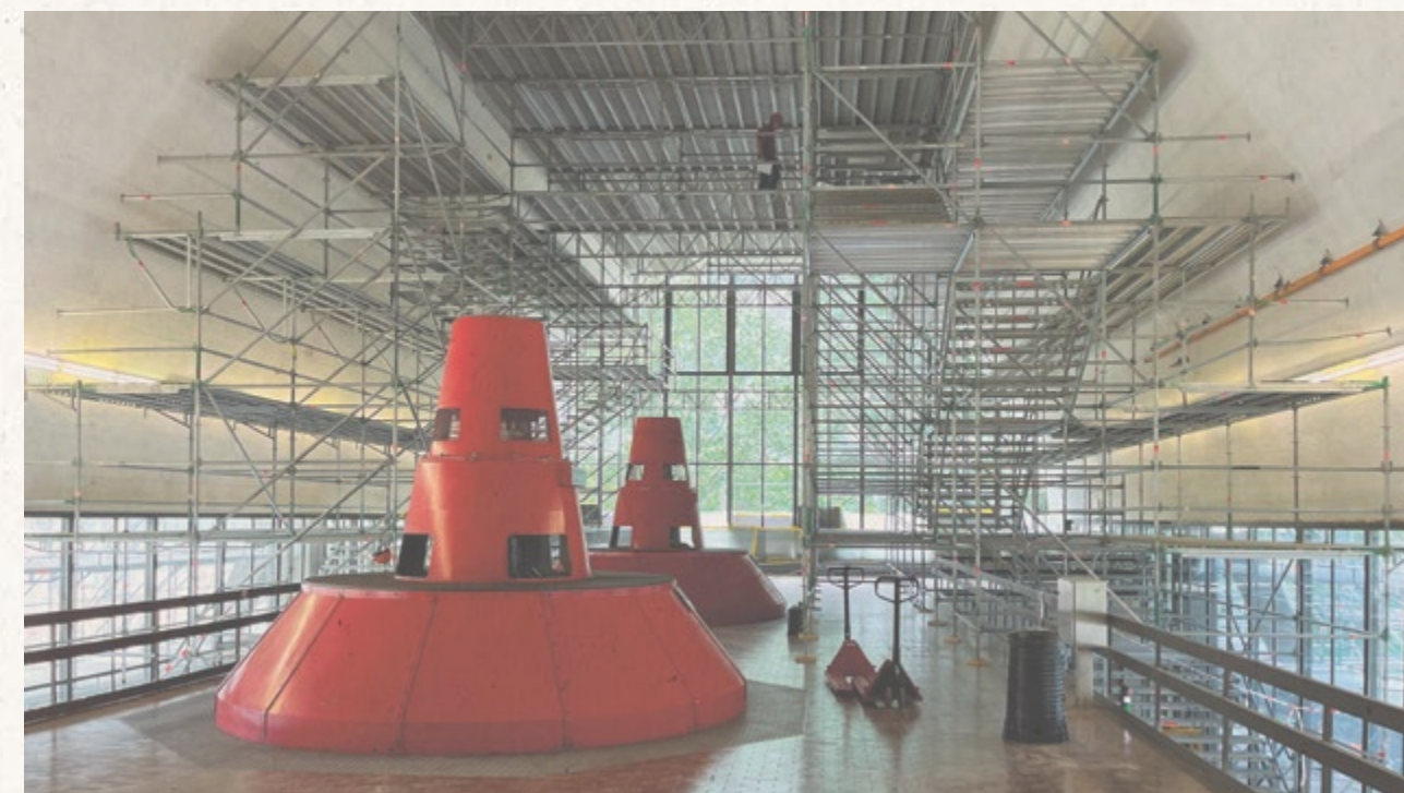
Lavori di bonifica della volta della Centrale Nuova Biaschina
