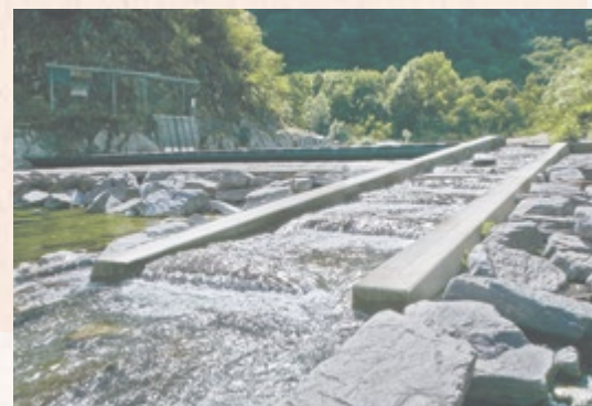
Rampa di risalita dei pesci
