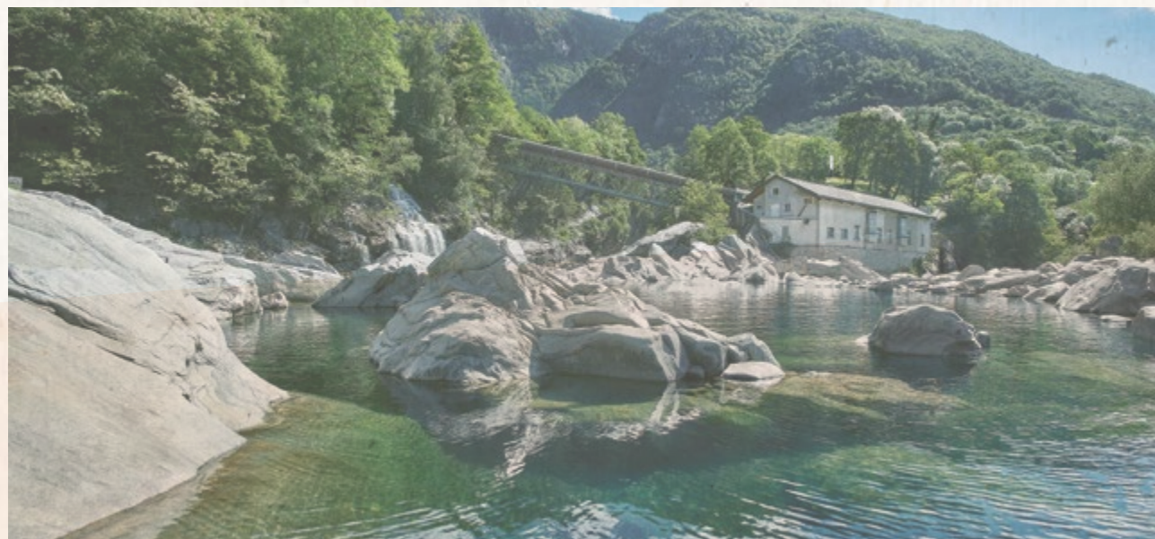
Centrale di Ponte Brolla
