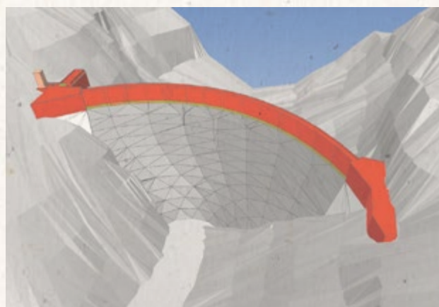
Progetto di innalzamento della Diga del Sambuco
